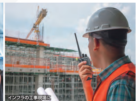
インフラの工事現場に
